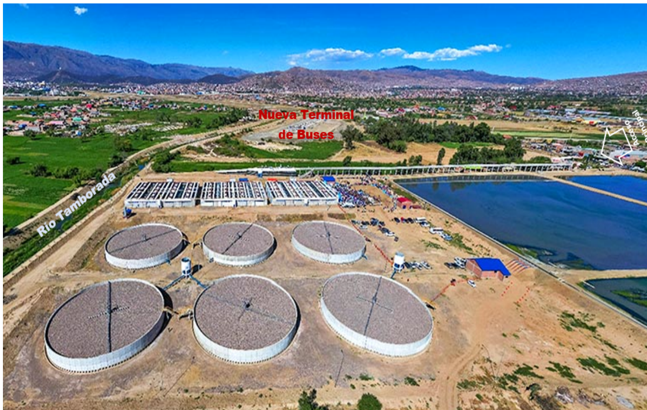
Figura 6 Nueva Planta de Tratamiento de Aguas Residuales de Albarrancho
