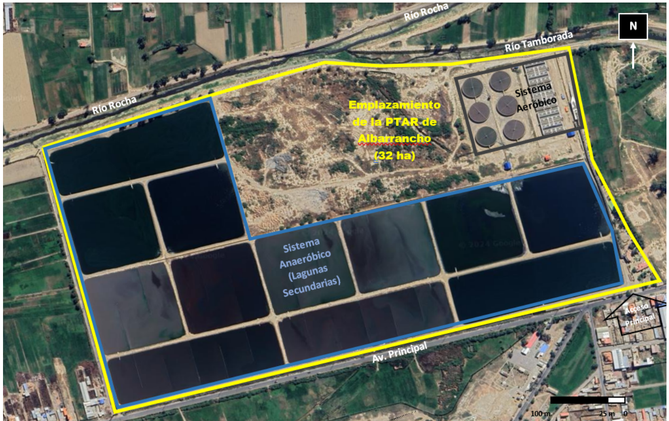
Figura 5 Nueva Planta de Tratamiento de Aguas Residuales de Albarrancho
